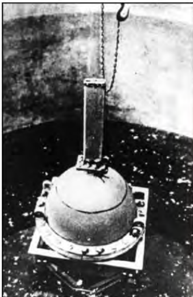
Uno dei primi reattori sperimentali di Heisenberg a Lipsia, dove l'uranio è presente in lastre immerse nell'acqua pesante
