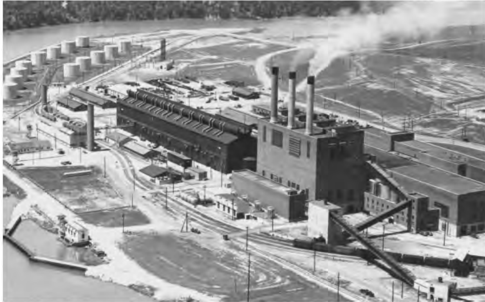
impianto S-50 (OakRidge) per la separazione termica a diffusione liquida dell'uranio 235
